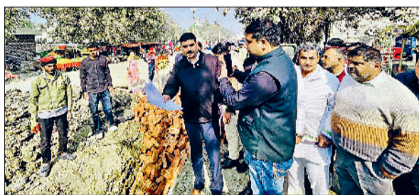
पूंडरी। सीवरेज निर्माण कार्य का निरीक्षण करते विधायक सतपाल जांबा।
